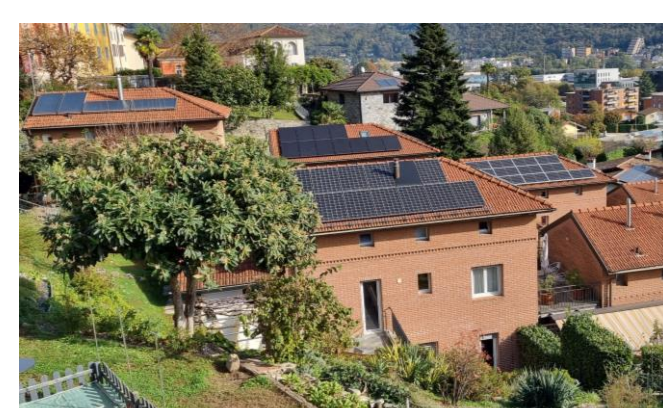
Monofamiliare 4 persone, 250 m 2 · FV 6.4 kWp batteria da 10 kWh
