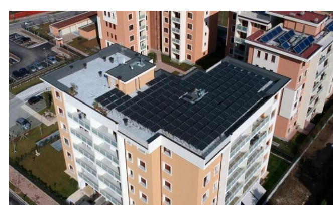
Plurifamiliare (+RCP)SUL: 1600 m 2 · FV: 30 kWp Batteria: 50 kWh
